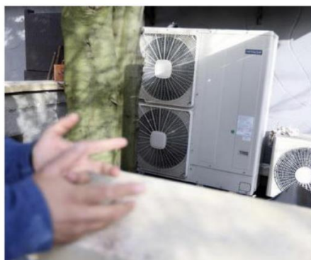
Les victimes signaient des contrats de prêt pensant que leur chantier était éligible aux primes d'État. PHOTO ILLUSTRATION MATTHIEU BOTTE
