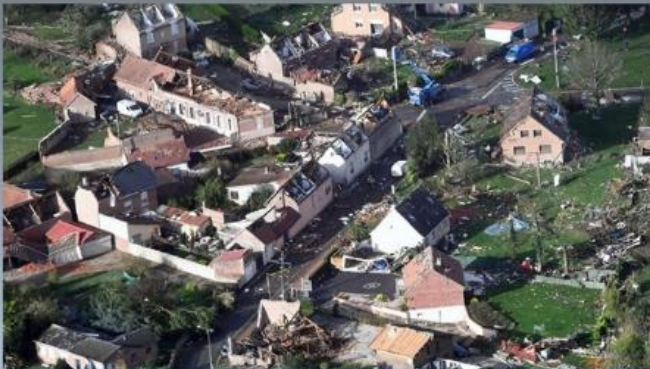
Toitures arrachées, murs en béton soufflés, arbres, pylônes pliés et d'importants dégâts dans ce village près d'ARRAS.
